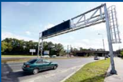
Tablica VMS na ul. Legnickiej
