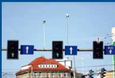
Kamery ITS (zliczające pojazdy)
