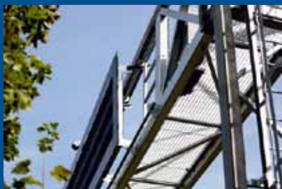
Bramownica VMS (znaku zmiennej treści)
