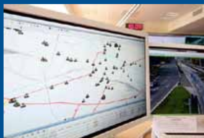
Konsola operatora podsystemu wideomonitoringu
